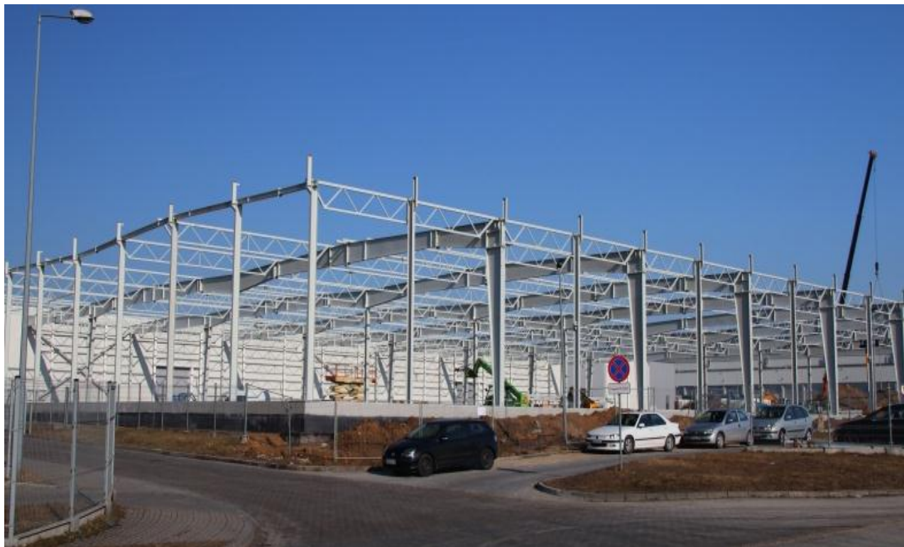
Nowe Inwestycje w Strefie Ekonomicznej w Radomsku w 2018 r. przy ul. Przedsiębiorców i Stolarzy - budowy zakładów firm: Ontex, RCO, Cobra Yachts, Cortizo i Aquila.
