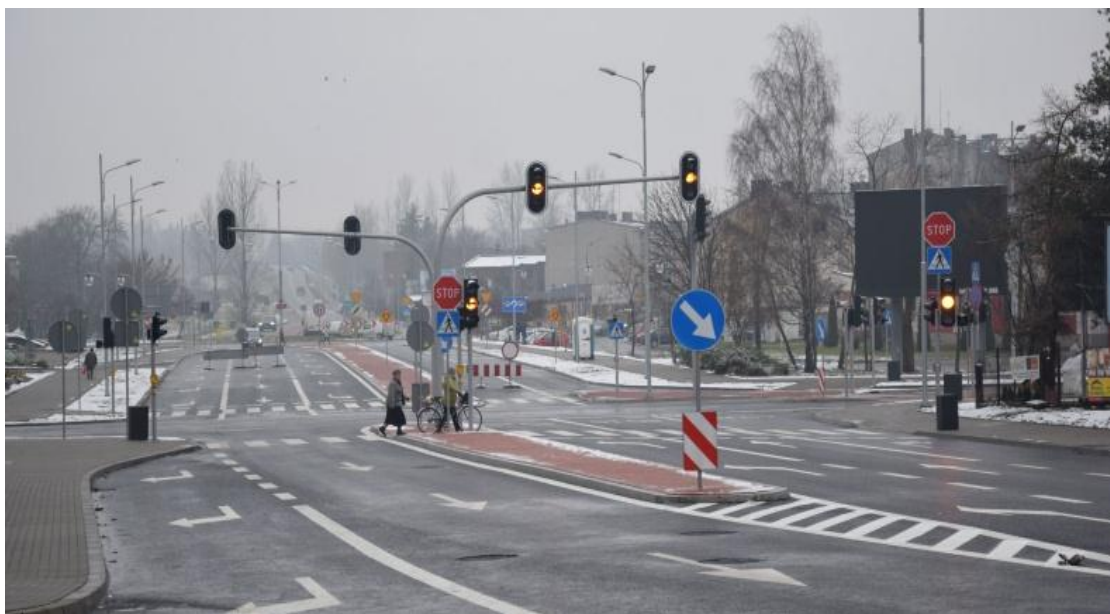
Otwarcie po przebudowie skrzyżowania ulic Brzeźnickiej i Krakowskiej (DK 42 i 91, grudzień 2018 r.).
