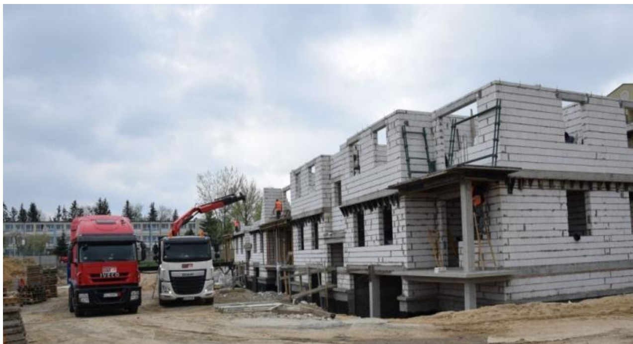
Towarzystwo Budownictwa Społecznego w Radomsku w trakcie budowy nowego budynku wielorodzinnego przy ulicy Sadowej.
